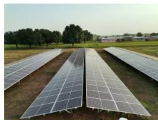
Mali: Ländliche Elektrifizierung
